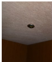
<天板の下>ボルト締め
