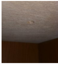
＜天板の下＞穴貫通
