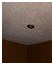
<天板の下>ボルト締め
